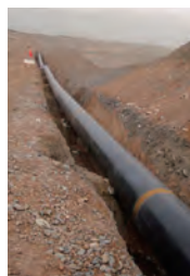
パイプライン敷設状況
